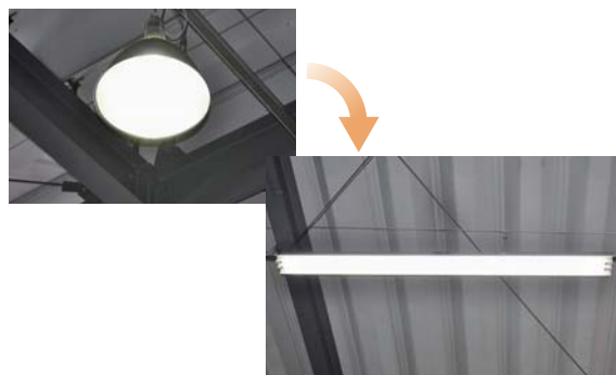
水銀灯(400W×1灯)を高効率蛍光灯(86W×2灯)に代替
